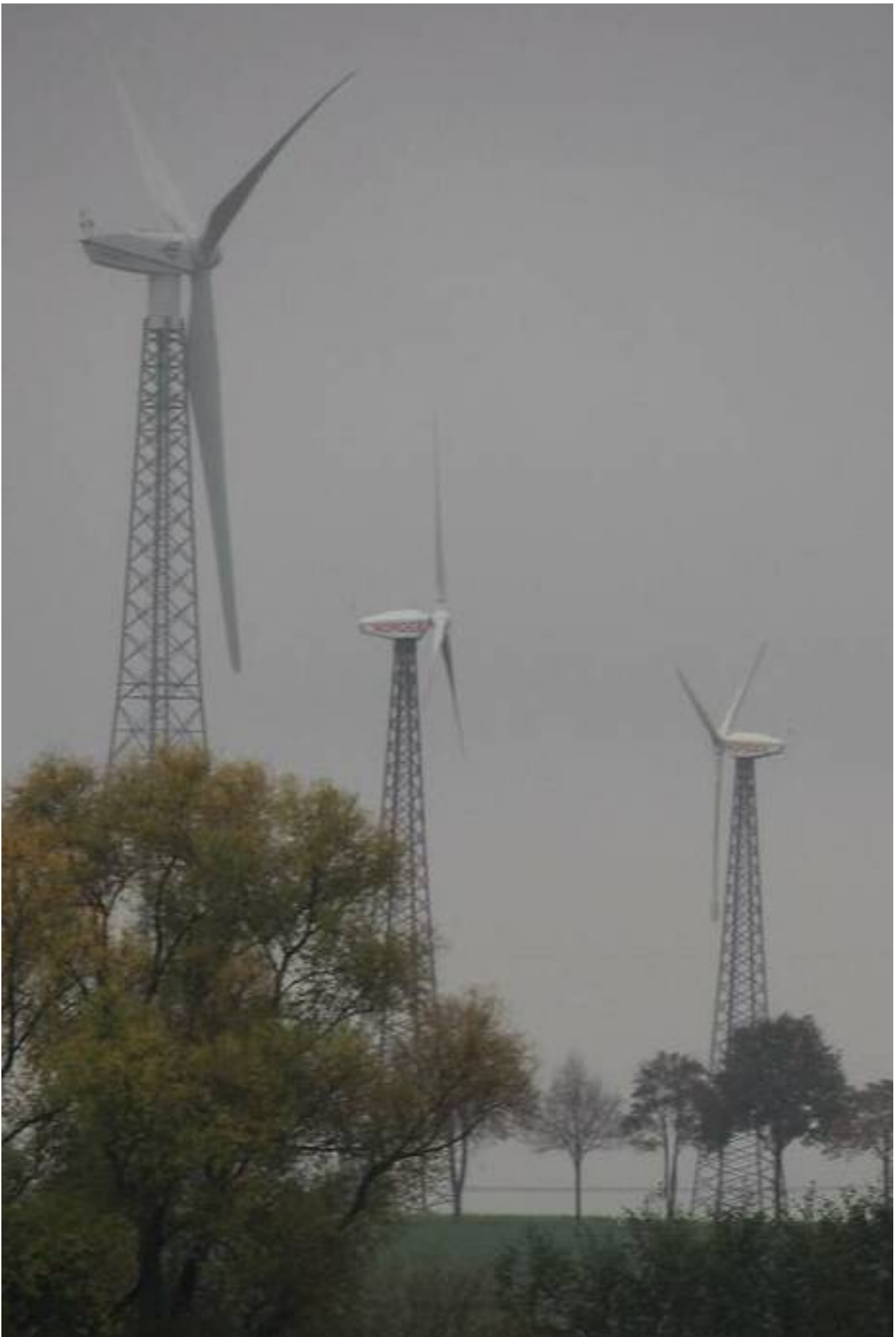
Die Windräder der Gesellschaften Gegenwind und Seitenwind sind 1993, 1994 und 1995 errichtet worden. Foto: MÜLLER
